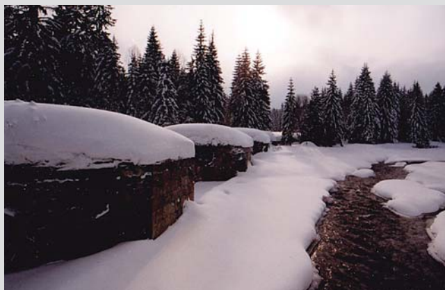
Pilíře mostu na Rechlích ještě bez mostu 1994.
