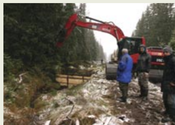
Rušení kanálů na svazích bylo technicky velmi náročné. Říjen 2014. Foto: Ivana Bufková
