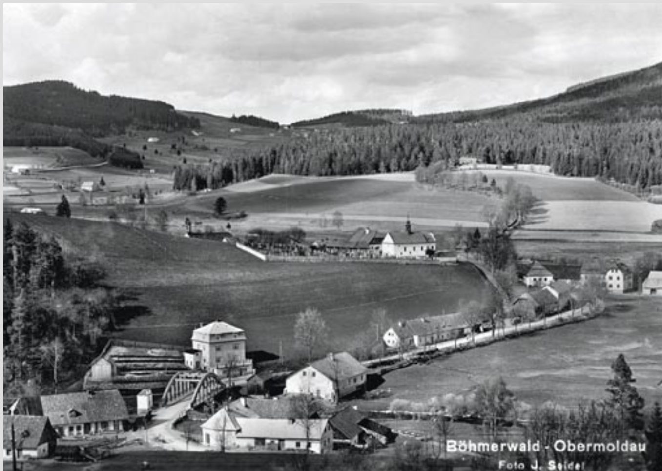
Betonový most přes Teplou Vltavu v Horní Vltavici z roku 1927. Foto: Josef Seidel, okolo 1930
