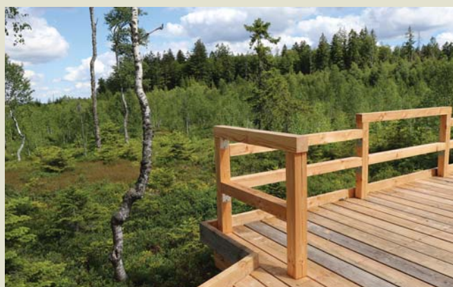
Na řadě míst dochází k opravám stezek a terénní infrastruktury. Nový chodník přes Finsterauer Filz.
