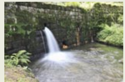
Kamenná hráz největší regulační nádrže na Zlatém potoce má délku 42 m a výšku 5,5 m.
