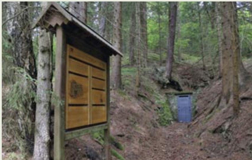
Štola Bedřich byla propojena šikmou šachtou se štolou Kristýna.
