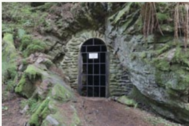
Jedna z mnoha štol v severním svahu Amálino údolí zabezpečená mřížemi.
