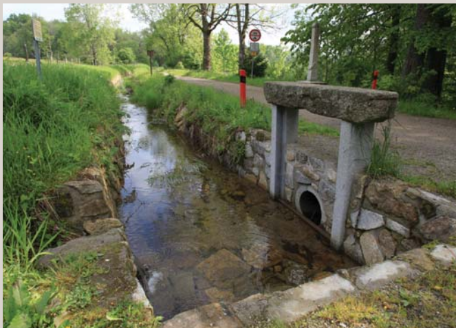
Andreasovo stavidlo a kamenný sloup s kovovým křížem z roku 1740.
