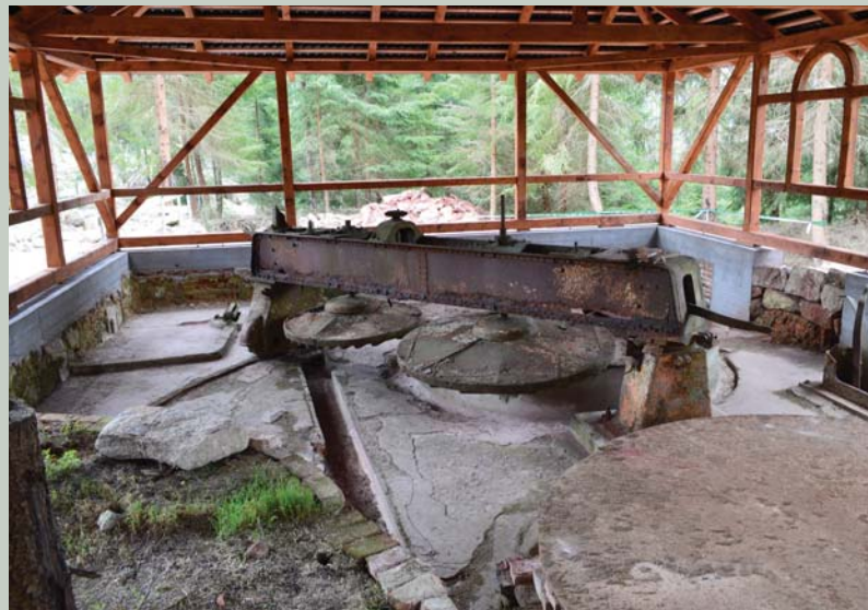
Obnovené základy budov Grafenried. Foto: Daniela Hlinková
